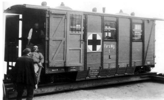
In der Rolle als Personenwagen liegen die Tragen in den Staukästen, der Schild zwischen zweiten und drittem Fenster zeigt die wagenfarbene Rückseite. Bei Verwendung als Lazarettwagen wird dieser Schild umgedreht und zeigt das Rote Kreuz auf kreisrundem weißem Grund.
